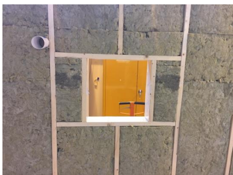
Montering av fönster och rör för ventilation
