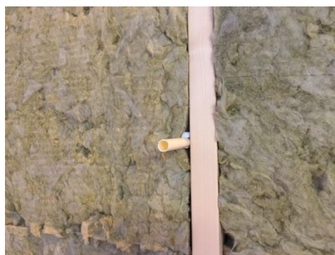
Montering av rör för el
