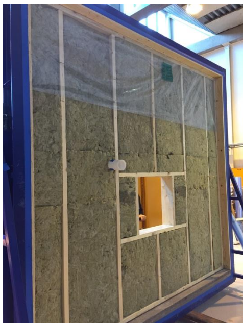
Provvuppställningen sedd från insidan före montage av läkt som ersätter regler för ett installationskikt, endast en del av lufttätningssystemet är monterat.
