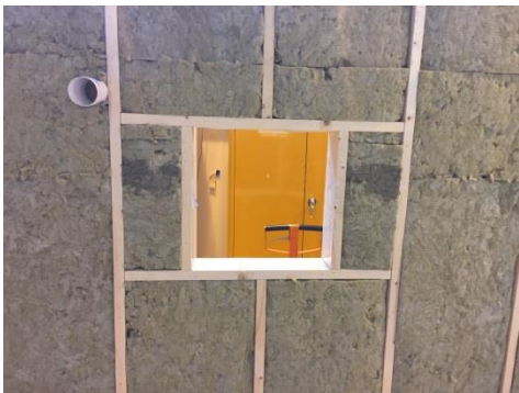
Montering av fönster och rör för ventilation
