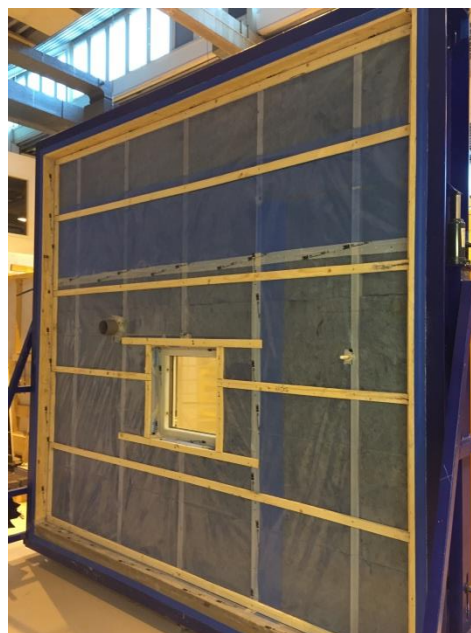
Montage av läkt som ersätter regler för ett installationskikt, hela lufttätningssystemet är monterat.
