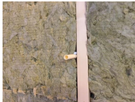
Montering av rör för el
